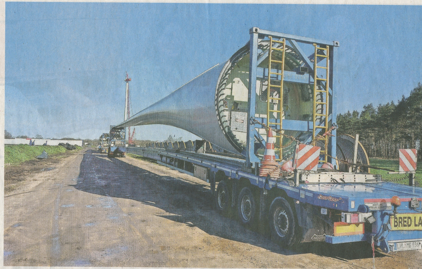
Zwischen Weddelbrook und Lentförden werden zurzeit fünf Windkraftanlagen gebaut, die auch in Bad Bramstedt zu sehen sein werden. Jedes einzelne Rotorblatt wird mit einem Schwertransporter angeliefert.
